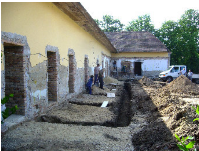
az épület udvar felé bővülő részének alapozása is megkezdődött
