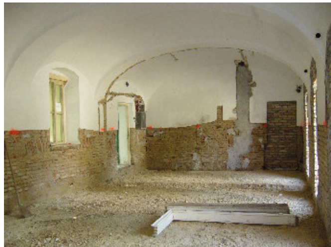
a szép boltíves födém megmarad, felülről kerül rá vastag szigetelés.
